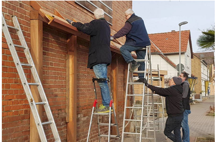
Die Mitglieder des Bürgervereins bauen die Schaukastenanlage gegenüber der Tankstelle in Jeinsen ab.
