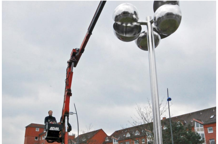
Metallbauer Stefan Kathöwer installiert die Plastik aus Edelstahl mit Hilfe seines Kranes auf dem Kreisel Wülferoder Straße.
