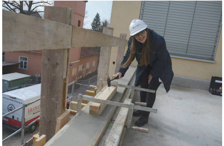
Zum Richtfest schlägt Bürgermeisterin Ramona Schumann einen Nagel in einen Holzbalken auf der zweiten Etage des Neubaus.
