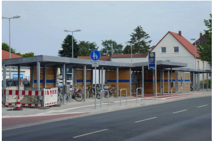
Der Bau der Bike+Ride-Anlage an der Schöneberger Straße steht kurz vor dem Abschluss.
