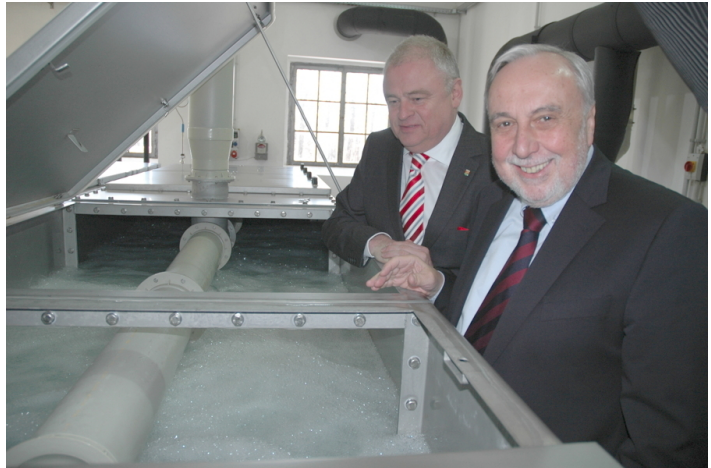
Der enercity-Vorstandsvorsitzende Michael Feist (rechts) und Laatzens Bürgermeister Thomas Prinz machen sich vor Ort ein Bild von der neuen Entsäuerungsanlage.
