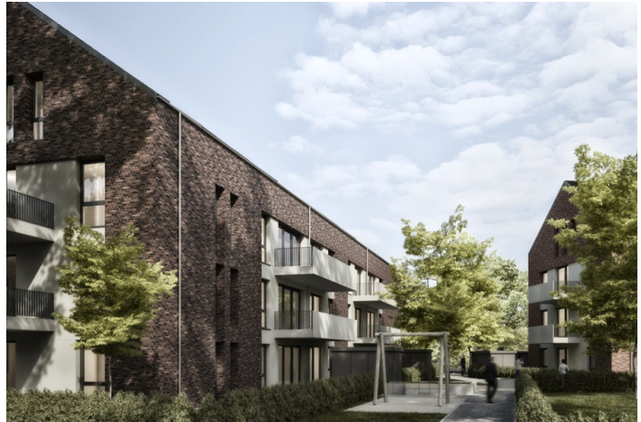
Auf dem Gelände des ehemaligen Sarstedter Bauhofes entstehen 48 Sozialwohnungen.
