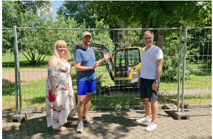
Nadine Dwenger (von links), Matthias Wiesner und Georg Thomas freuen sich über den Start der Bauarbeiten für den neuen Spielplatz in den Bruchwiesen.
