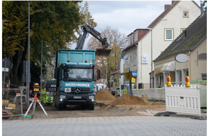
Die Grundsanierung der Straße am Friedrich-Ebert-Park soll im Februar nächsten Jahres beendet sein. / Foto: R. Kroll
