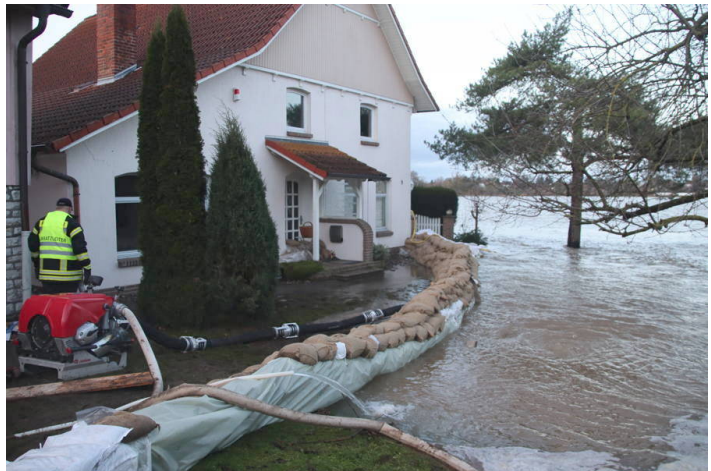
In Lauenstadt werden Häuser mit etlichen Sandsäcken vor den Wassermassen geschützt.
