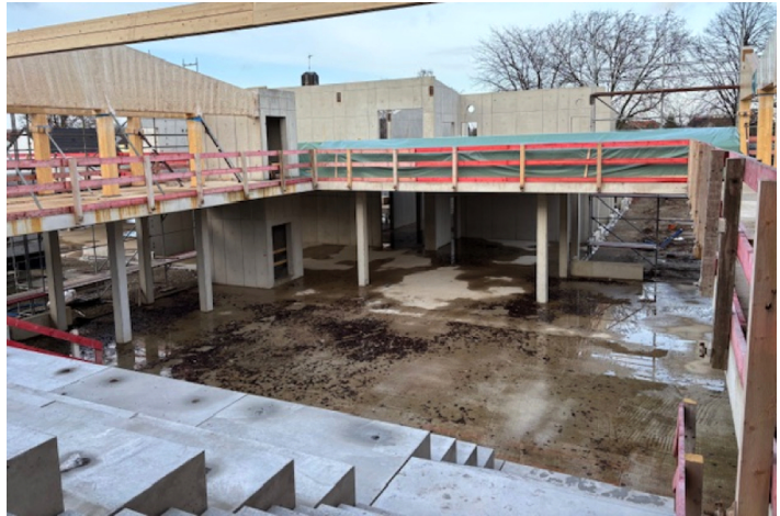
Der Neubau der Grundschule Gieselstieg liegt im Zeitplan.
