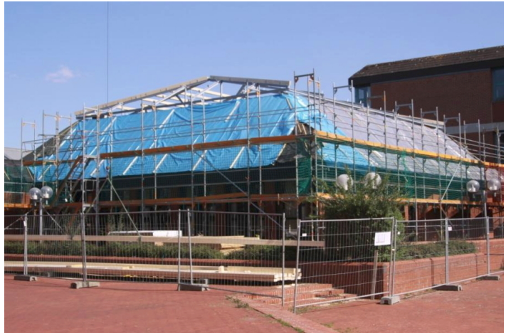
Das Forum des Erich Kästner- Schulzentrum ist voll eingerüstet und bekommt ein neues Mansarddach.
