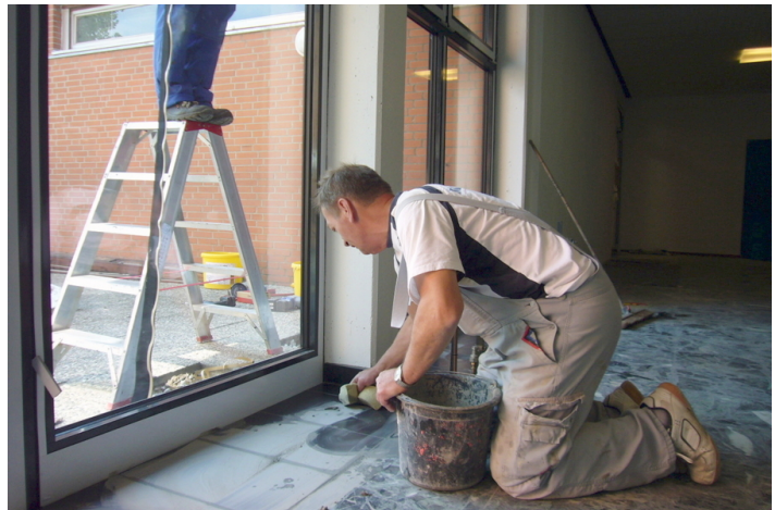
Manfred Körner verputzt die Fußbodenplatten vor der neuen Fensterfront im Forum der Grundschule Pestalozzistraße.
