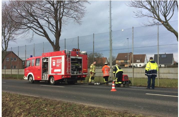
**Mithilfe der Tragkraftspritze leitet die Feuerwehr das Wasser um, damit die Hauptstraße nicht überflutet wird.**
