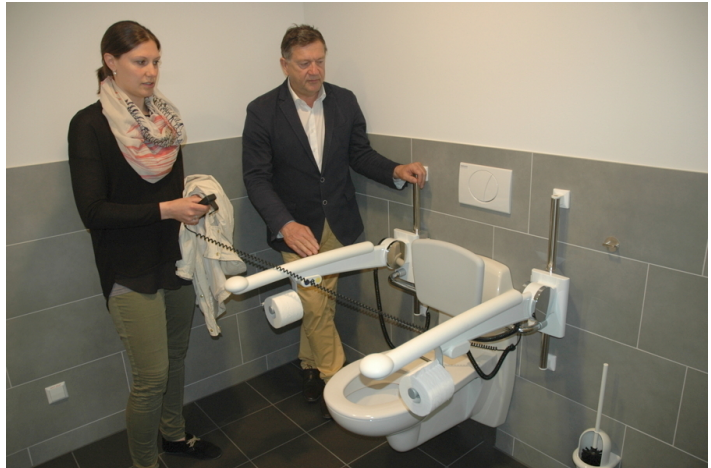
Bürgermeister Claus Schacht und Lena Tabari vom Team Gebäudewirtschaft demonstrieren das neue höhenverstellbare Behinderten-WC.
