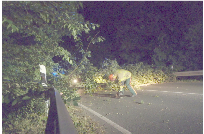
Die Feuerwehr beseitigt in der Nacht den Ast von der Bundesstraße 443.
